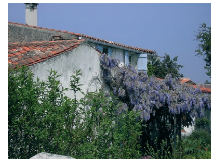
Les treilles ou glycines utilisées en protection d'été des façades sud, Marennes
