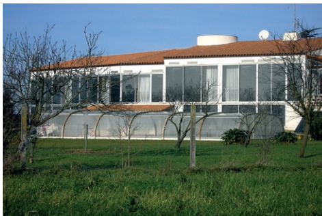
Serre climatique en façade sud, Bourcefranc
