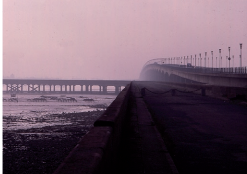
En 1966, le Conseil Général réalise le viaduc qui accueille un trafic en pointe de 15000 véhicules/jour en moyenne (2005).
